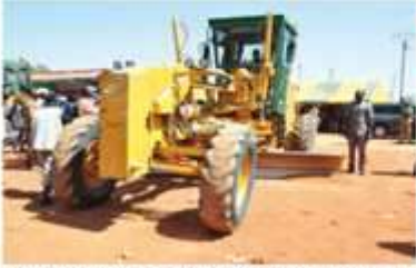
Le Premier ministre, Yacouba Isaac Zida inspecte les travaux de bitumage de la section urbaine de la route nationale n°4 à Ouagadougou
