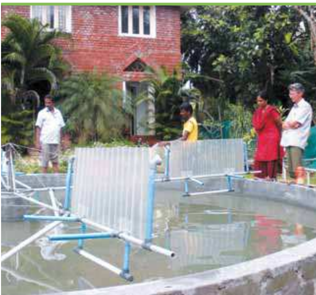
Construction d'un bassin circulaire pour la culture de spiruline en Inde
